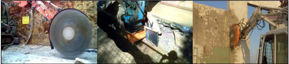
Abbildung 34: Trennwerkzeuge: Baggeranbausägen/fräsen, hier Anwendungsbeispiele der Fa. Echidna Technologies Pty Ltd, Australien
